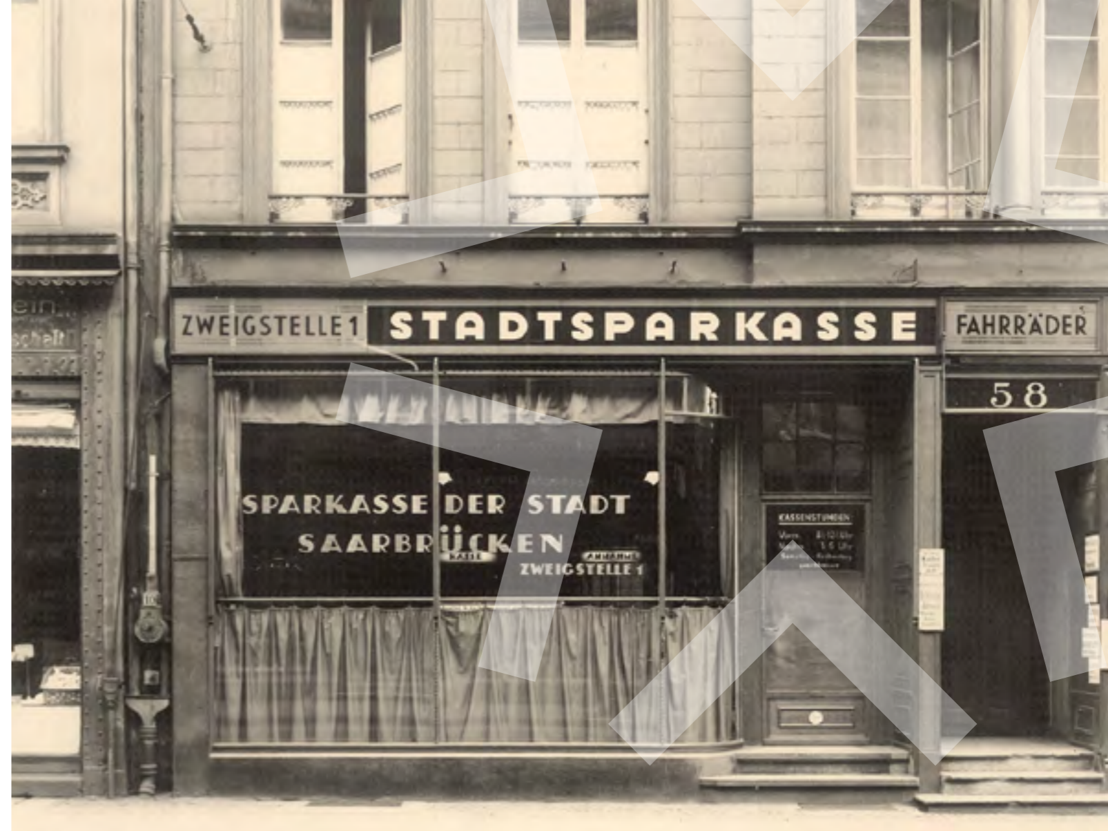
Zweigstelle der Stadtsparkasse in der Eisenbahnstraße um 1920
