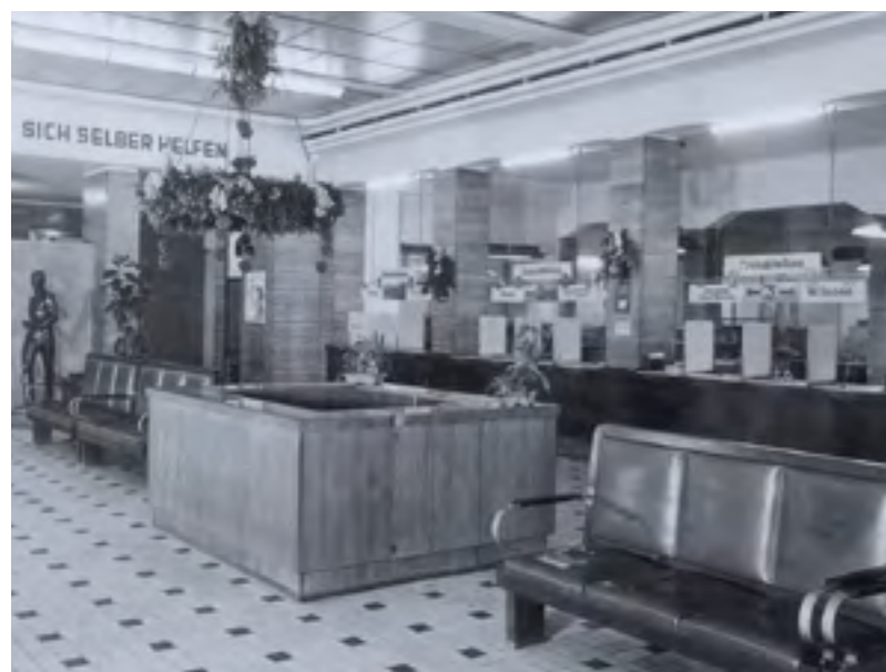
Die elegante Schalterhalle in den 1950er Jahren
