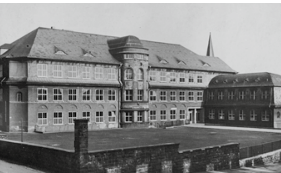
Gebäude der Knabenmittelschule in Saarbrücken-Malstatt, 1950
