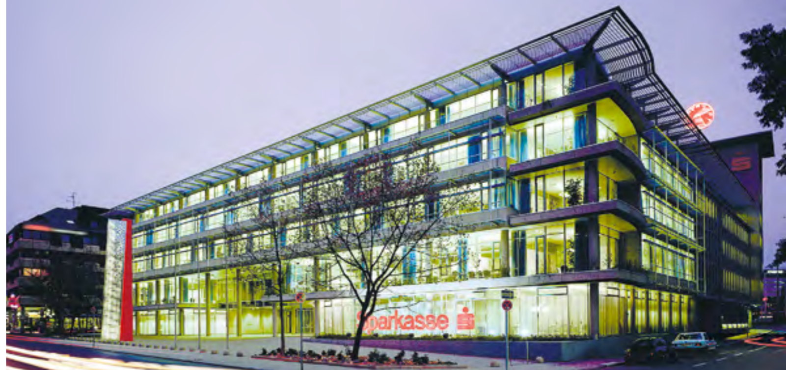
Zukunftsorientiert – die moderne Sparkassenzentrale am Neumarkt
